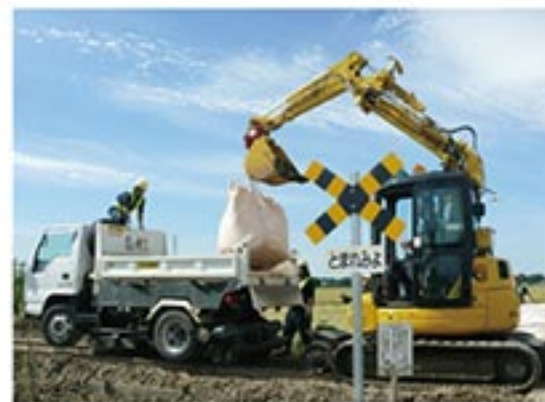
重機によるバラスト運び込みの様子。
