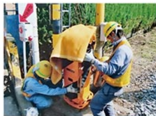
踏切遮断機交換工事の様子。
