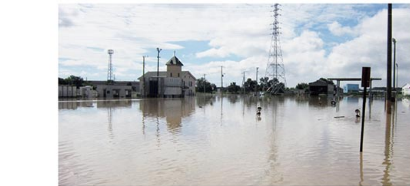
9月11日 水海道車両基地水没の様子。基地全体が被害を受けました。
