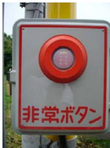
支障報知装置押しボタン
