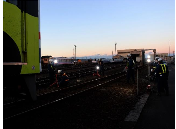
照明機材の搬入・設置
